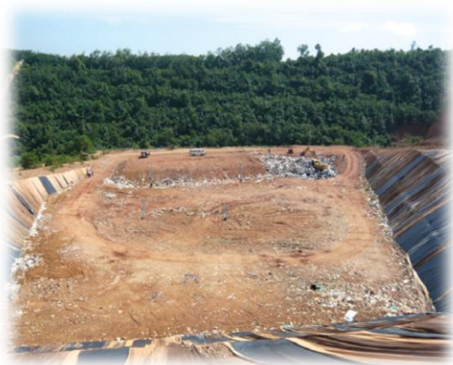
ภาพที่ 4.16 วิธีฝังกลบแบบหุบเขา
